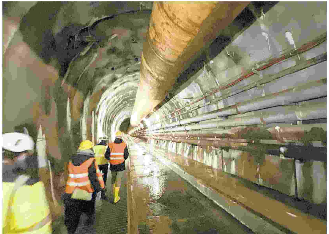
Il cantiere Tav di Chiomonte ha ripreso a lavorare nei mesi scorsi
