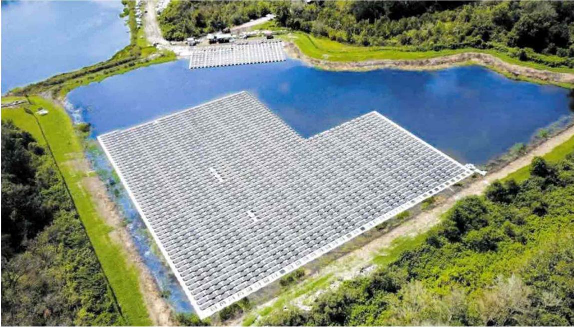
Al centro, una veduta di Seoul, capitale della Corea del Sud. Accanto, fotovoltaico galleggiante di Orlando (Florida)
