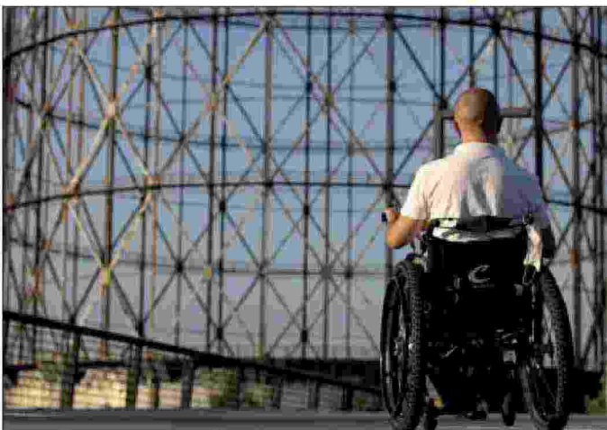
Roma capitale delle barriere architettoniche (foto Ansa)
