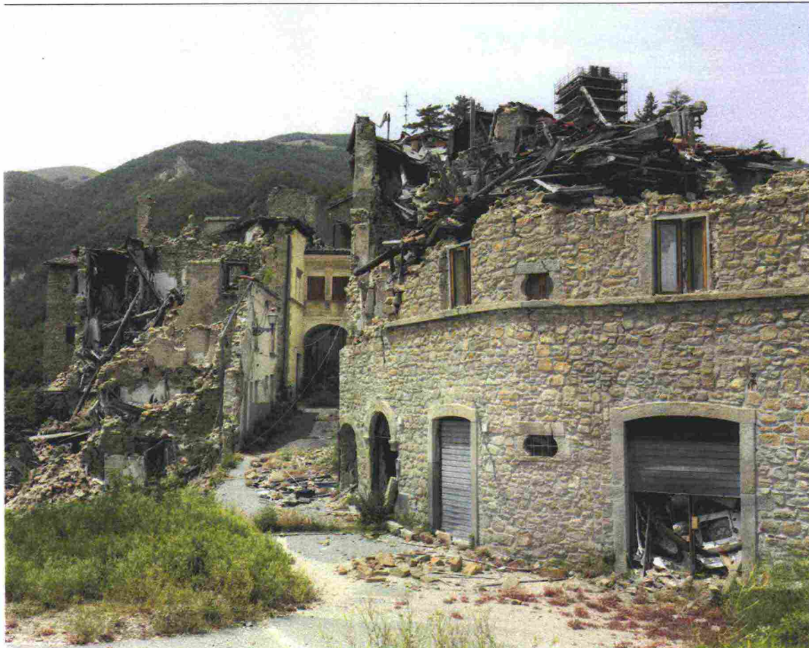
Uno scorcio di Arquata del Tronto, in provincia di Ascoli Piceno, distrutta dal terremoto
