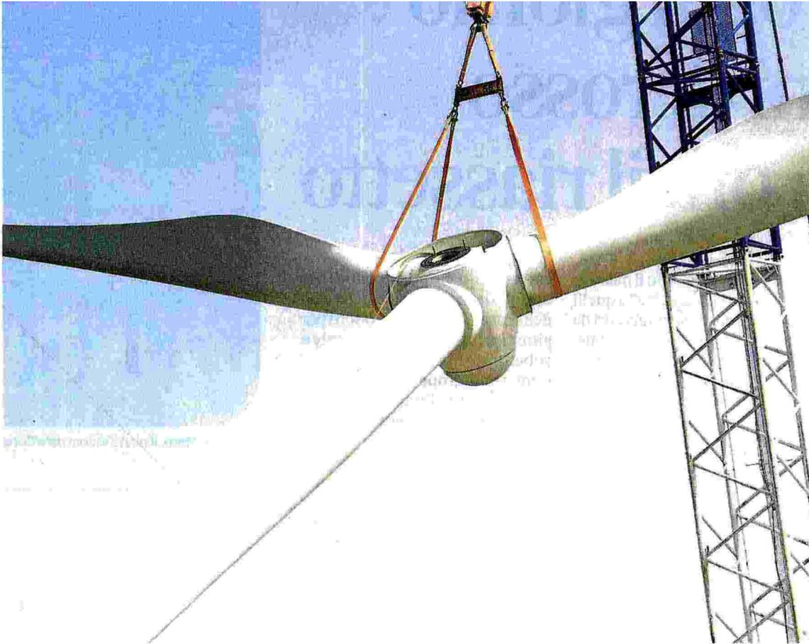
**Energia pulita.** Le fasi di assemblaggio per la messa in funzione di una pala eolica
