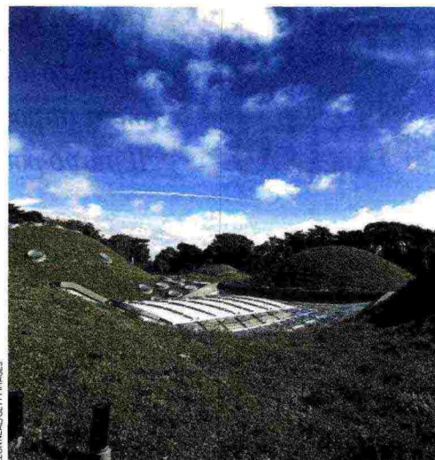
SAN FRANCISCO Il tetto della California Academy of Sciences
