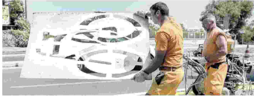
Posa della segnaletica per una corsia ciclabile (foto LAPRESSE)
