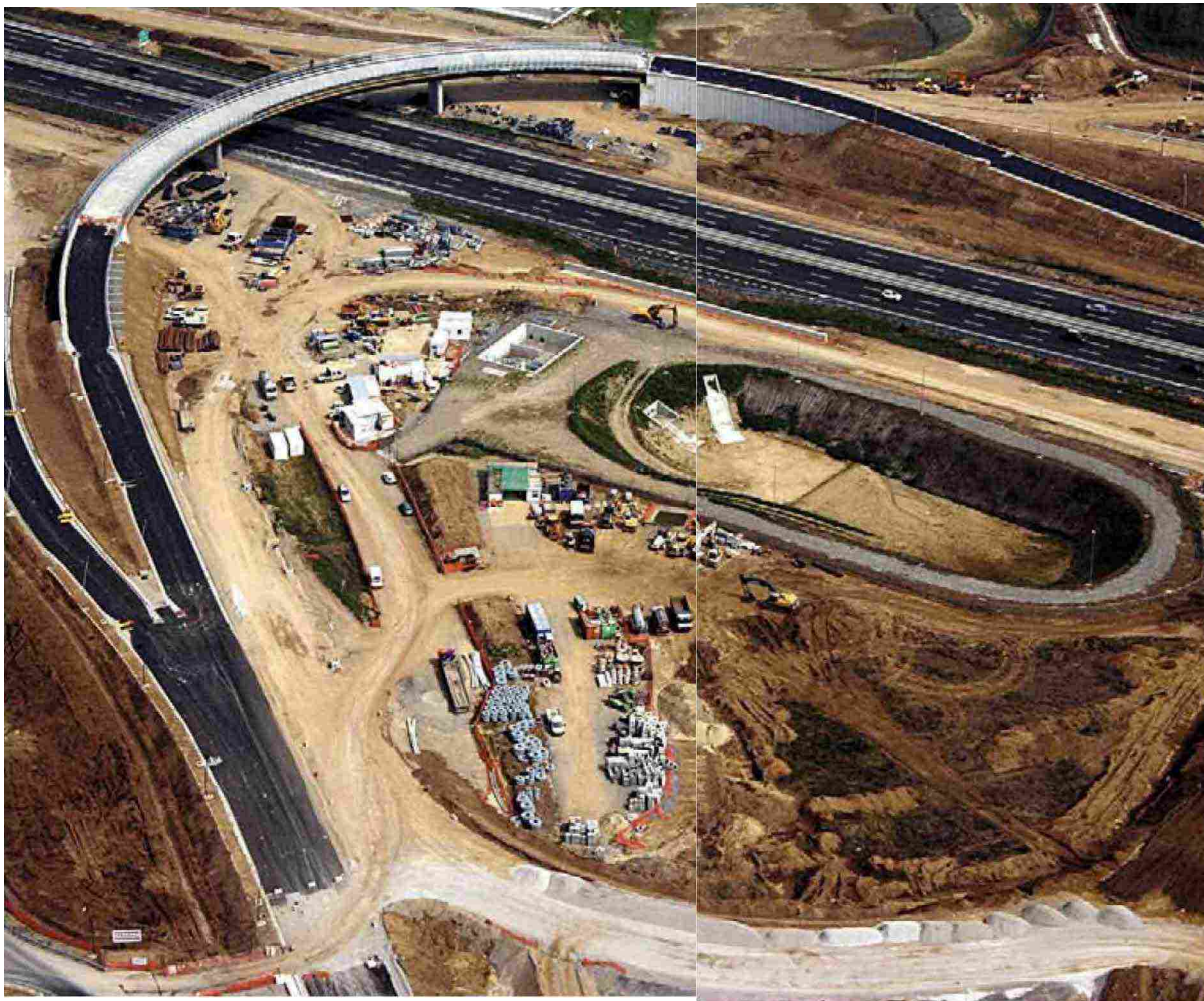
↑ Como, un cantiere in periferia
