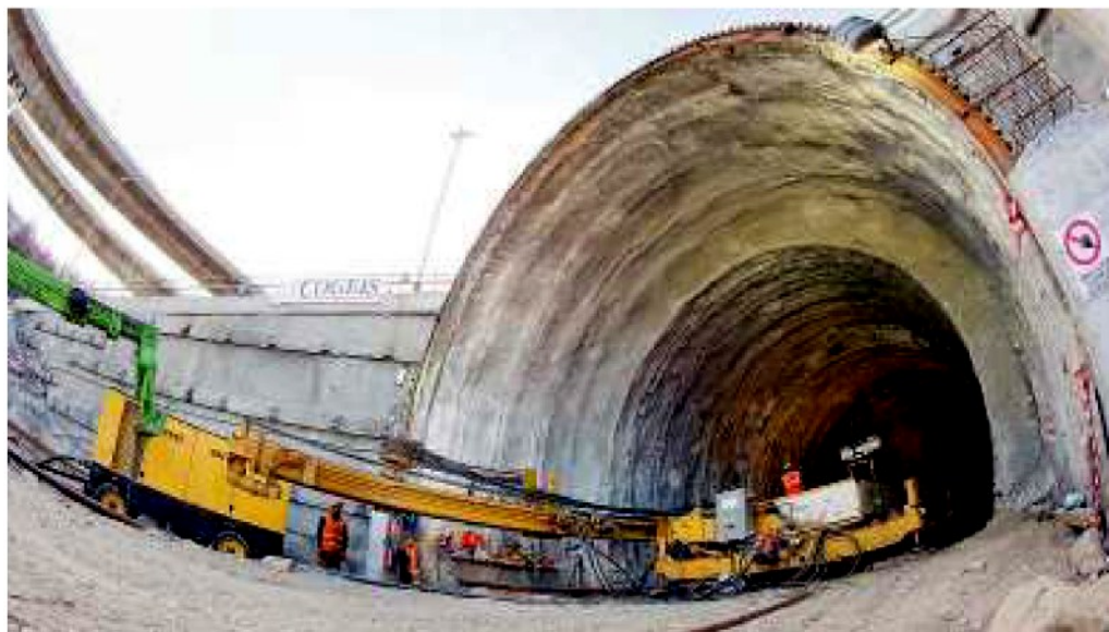
Il cantiere di Chiomonte
