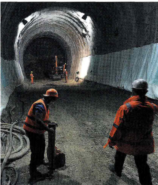
I lavori nel cantiere Tav rischiano di protrarsi per molti anni
