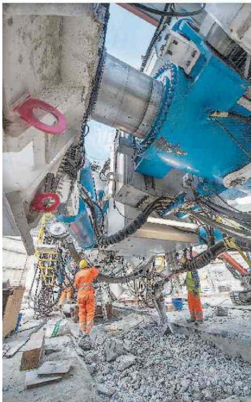
Il montaggio della talpa utilizzata a Chiomonte
