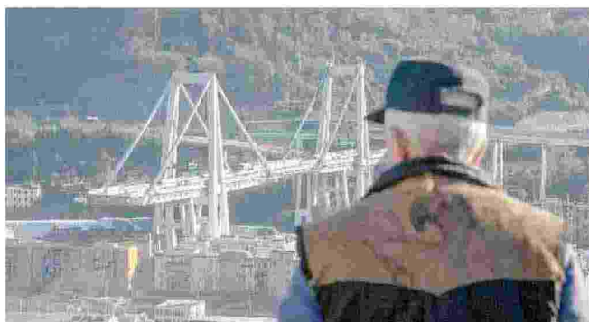
Genova, una veduta di ponte Morandi, crollato il 14 agosto scorso
