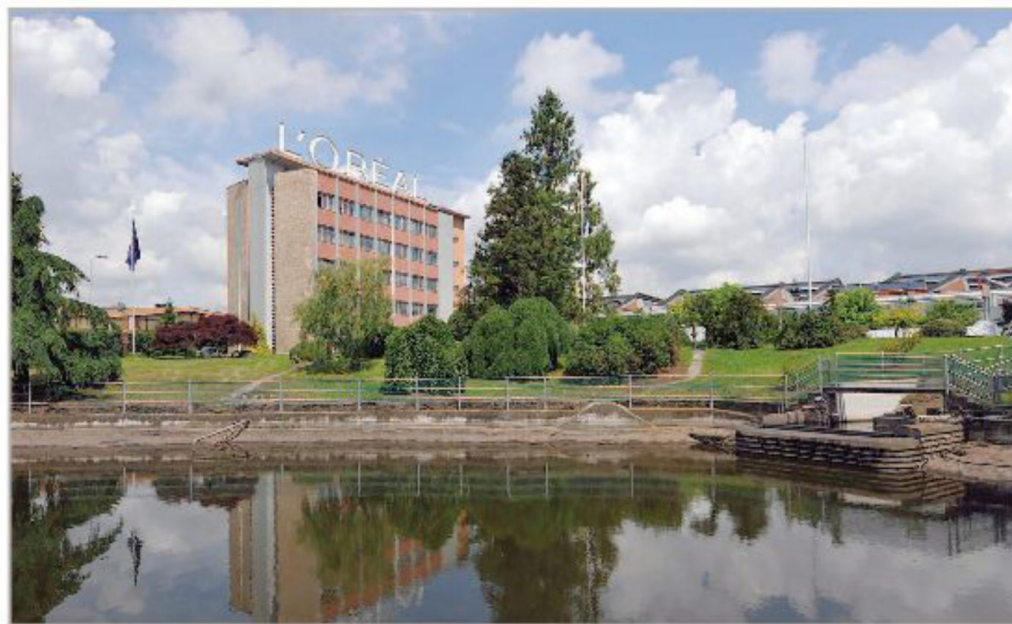
Settimo Nella foto, il rinnovato stabilimento di Settimo Torinese de L'Oréal: grazie a duecentoquaranta parabole a specchio può produrre 15 chilowatt/ora di energia e di conseguenza diffondere 7.800 tonnellate di anidride carbonica in meno nell'aria
