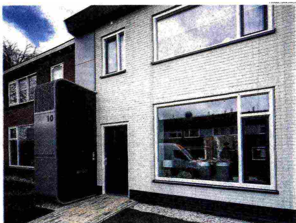
Paesi Bassi. Nella foto un caso di riqualificazione di un edificio effettuata in dieci giorni da un team guidato da Energiesprong
