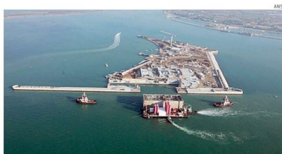
Progetto faraonico. Il primo grande cassone che andrà a formare la barriera mobile della bocca di porto Lido sud
