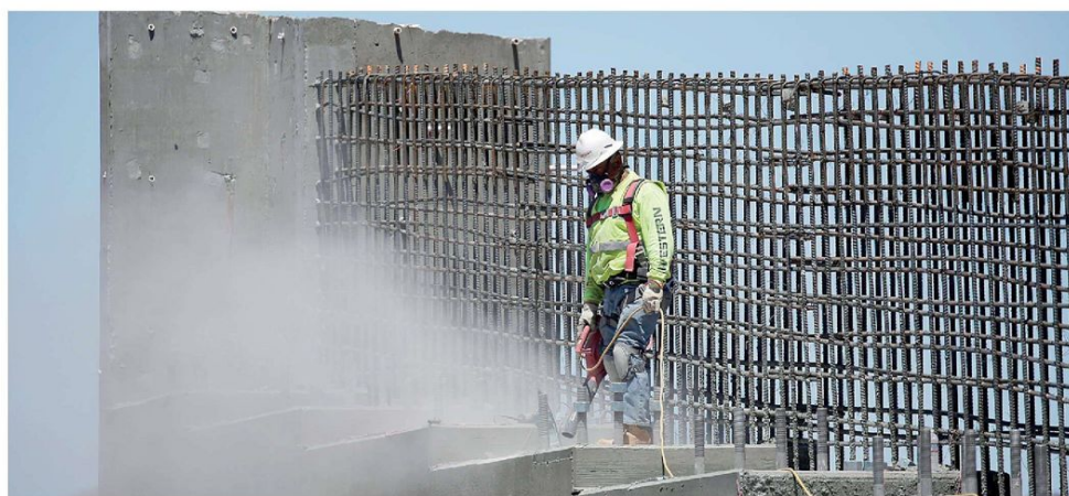
Grandi opere. Un operaio al lavoro sulla Interstatale 11 in Nevada, nei pressi di Boulder City
