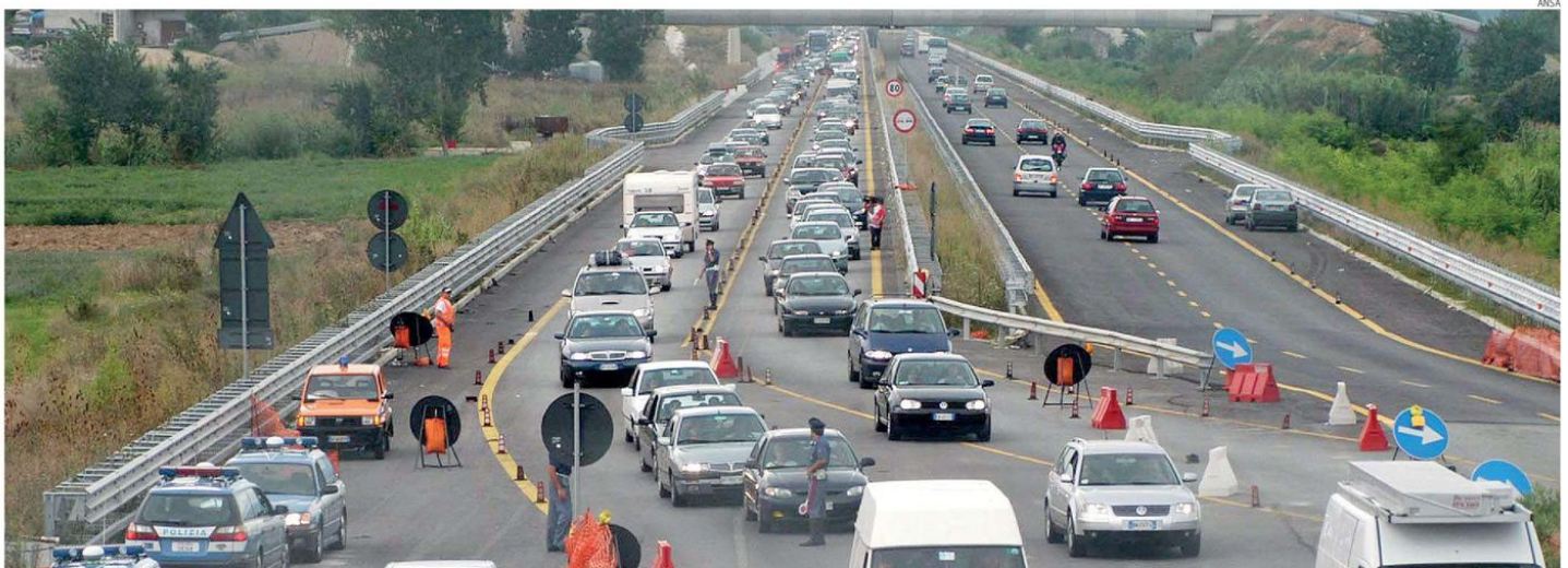
Regina delle incompiute. Incolonnamenti causati da un cantiere sulla Strada statale Jonica 106
