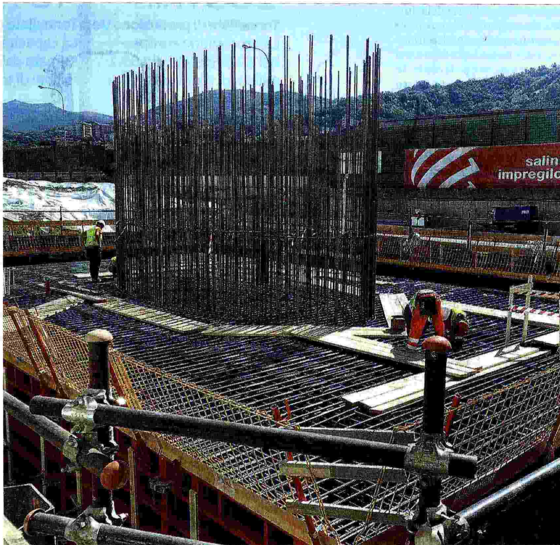
L'opera ideata da Renzo Piano L'armatura del primo pilone del futuro ponte sul Polcevera
