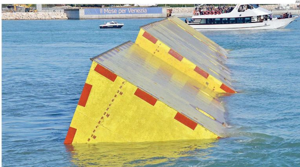
Dighe a scomparsa. Il Mose è formato da grandi paratoie mobili per tagliare l'acqua alta fuori dalla laguna
