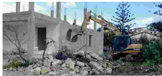
UNA DELLE DEMOLIZIONI ESEGUITE NEI MESI SCORSI NELLA ZONA DI LICATA
