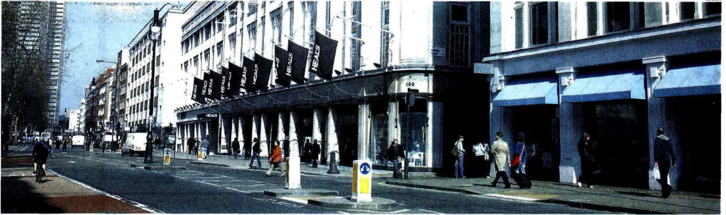
Second Life. La zona attorno a Tottenham Court Road beneficerà del progetto Crossrail, il nuovo collegamento ferroviario che porterà all'apertura di sei nuove stazioni in città
