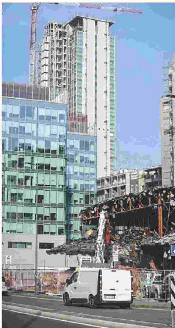
Prima. La demolizione in via Melchiorre Gioia, 2017 (LaPresse)
