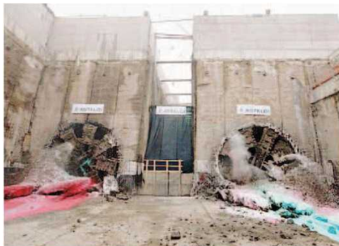
Le "talpe" della M5 si sono incontrate ieri nel cantiere di Citylife
