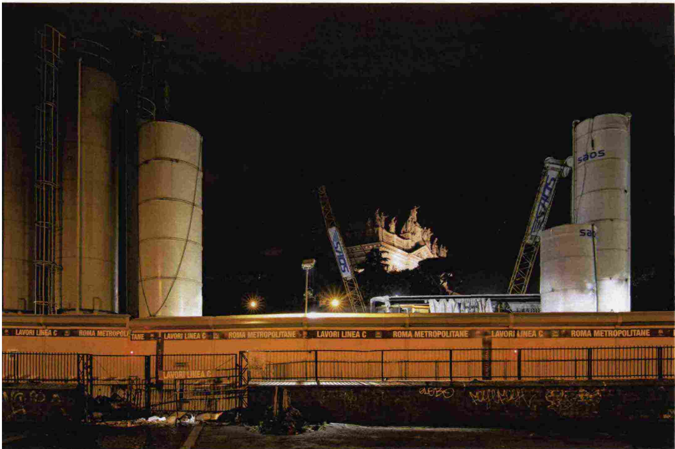
IL CANTIERE DELLA METRO C A VIA SANNIO (SAN GIOVANNI). SOTTO: IL SINDACO IGNAZIO MARINO. A SINISTRA: I LAVORI A VIA DEI FORI IMPERIALI
