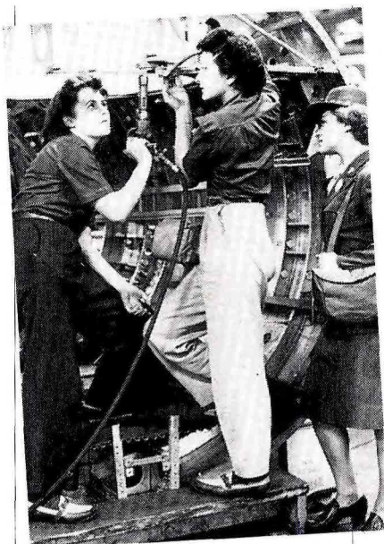
Il passato Una vecchia foto del '43 ritrae alcune operaie al lavoro in una fabbrica di Detroit (Ap)
