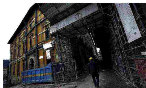
Ricostruzione Operai e impalcature nella vecchia università (foto Benvegnù-Guaitoli)
