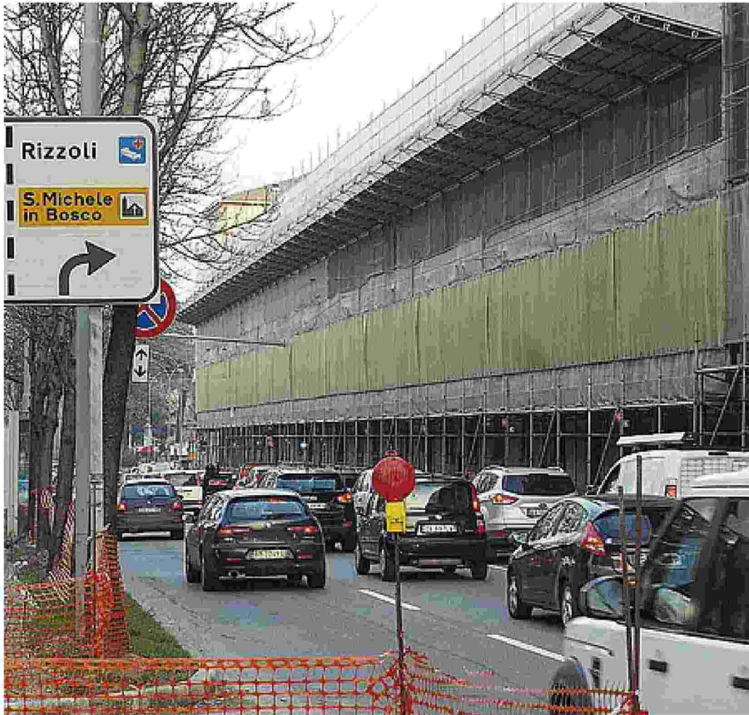
Il «muro» del Pirotecnico L'edificio su viale Panzacchi ingabbiato dalle impalcature per scongiurare nuovi crolli dopo quello del 2011
