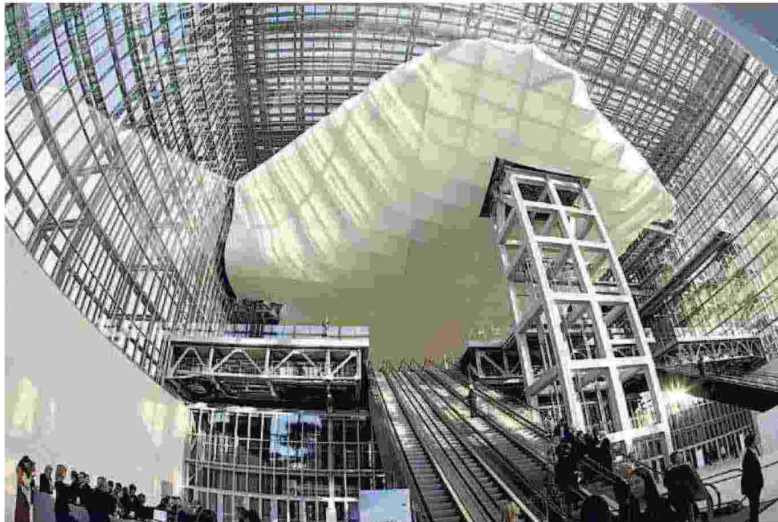
Il nuovo centro congressi dell'Eur progettato da Massimiliano Fuksas è costato 363 milioni di euro. Per realizzare la nuvola sono servite 18 mila tonnellate di acciaio e altrettante di cemento. Cento mesi la durata dei lavori: dal 2008 al giugno del 2016
