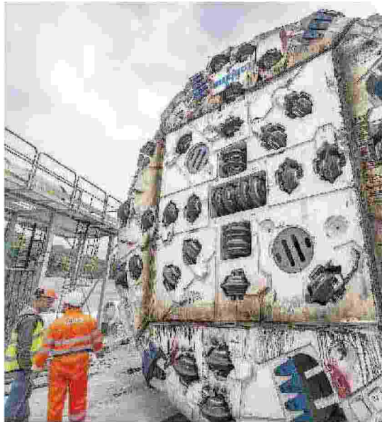
La talpa utilizzata per la galleria della Torino-Lione
