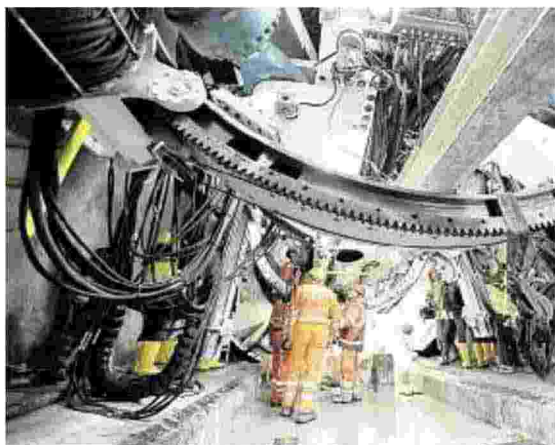
Lo scavo del tunnel per una linea ferroviaria
